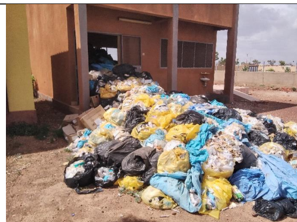
Photographie 5 : salle de stockage des déchets biomédicaux du CHR de Ouahigouya
