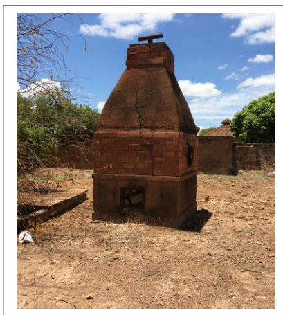
Brûleur du CM obsolète
